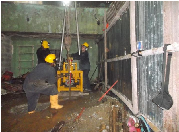
Fotografía 1 Maquina Petty – 54 ubicada en el sondeo 1
