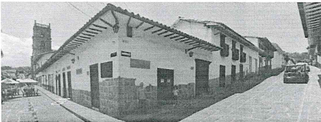
Imagen 7. Escalonamiento de los inmuebles, propio de la fisonomía de la Calle Real, perspectiva. Fuente: Google Earth.
