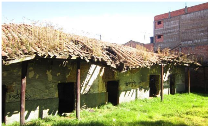
Restauración Estación del Ferrocarril Chusacá. Sibate, Cundinamarca
