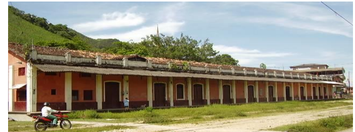
Mantenimiento Estación del Ferrocarril Cisneros, Antioquia
