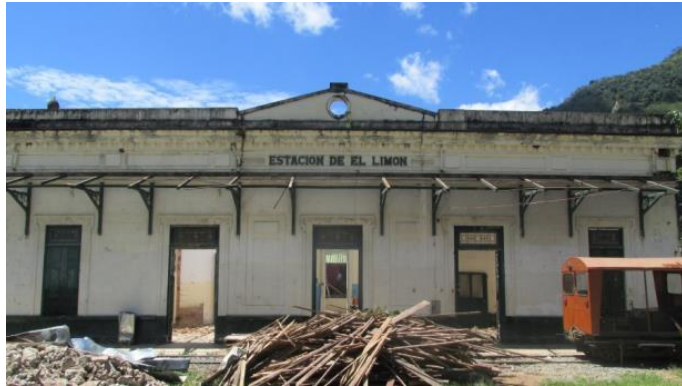
Mantenimiento Estación del Ferrocarril El Limón. Cisneros, Antioquia
