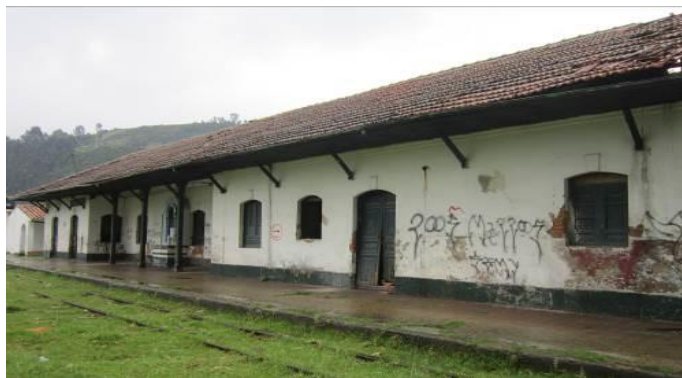
Restauración Estación del Ferrocarril Nemocón, Cundinamarca
