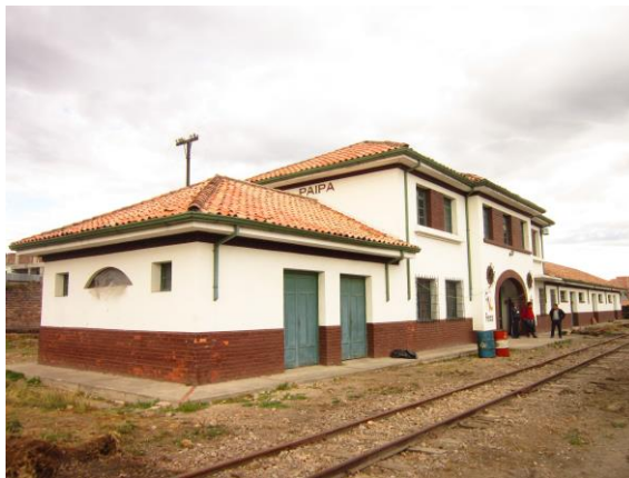
Estación Paipa, Cundinamarca. 2012
