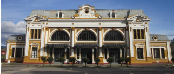
Mantenimiento Estación del Ferrocarril Chiquinquirá, Boyacá
