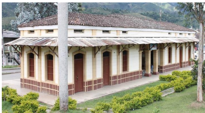
Adecuación Estación del Ferrocarril Piendamó, Cauca
