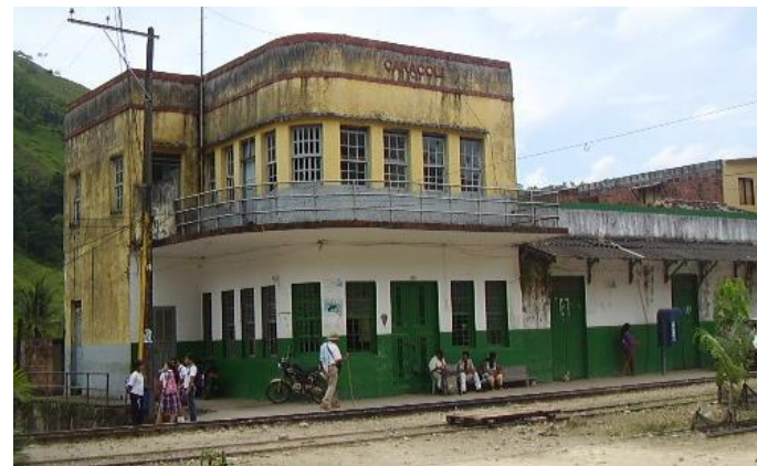
Restauración Estación del Ferrocarril Caracolí, Antioquia
