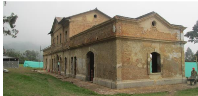
Restauración Estación del Ferrocarril Albán, Cundinamarca
