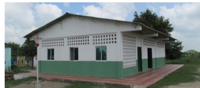
Adecuación Estación del Ferrocarril Algarrobo, Magdalena
