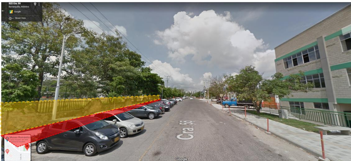
Imagen 187 Fotografía Carrera 55 donde se muestra la disminución del área de andén para destinarla a bahías de estacionamientos. Fuente: Google earth.
