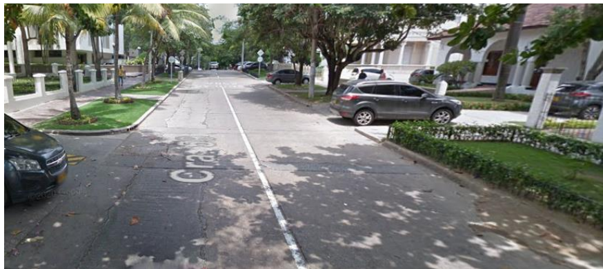
Imagen 138. Condición actual de la carrera 59.
