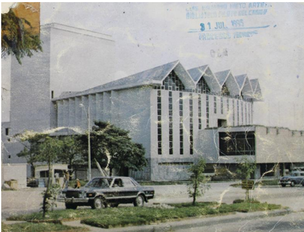
Imagen 25. Teatro Municipal Amira de la Rosa después de terminada la primera fase hasta 1980. Obsérvense los cambios introducidos en la fachada sur, en la que se elimina la envolvente de los calados y se incorpora un acceso a la terraza.
