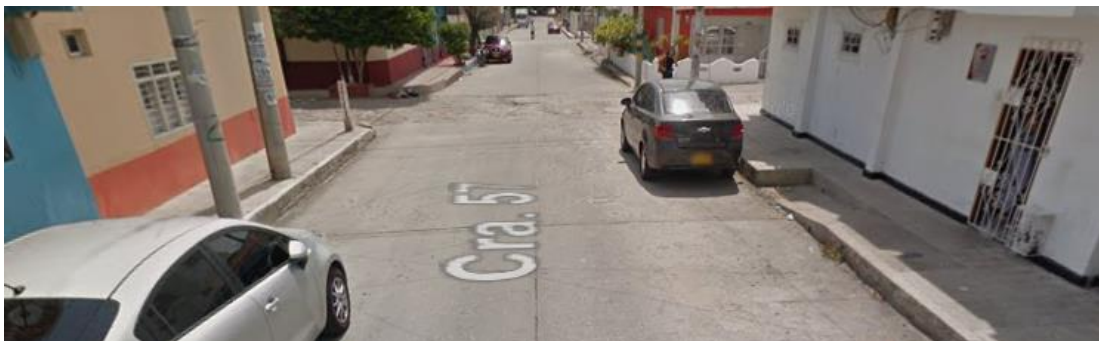
Imagen 136. Condición actual de la carrera 57.
