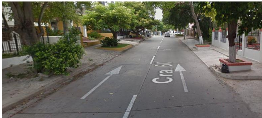
Imagen 141. Condición actual de la carrera 60.
