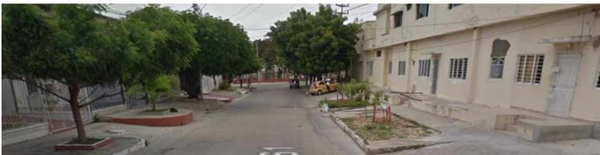
Imagen 143. Condición actual de la carrera 61.
