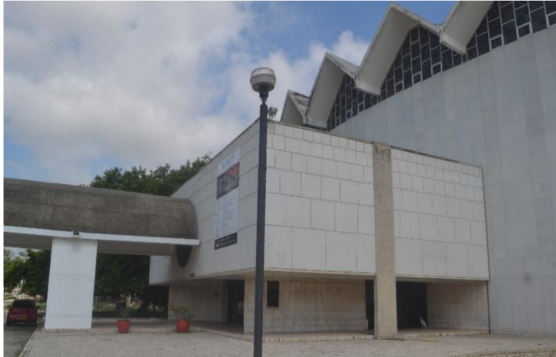
Imagen 205. Fachada sur o acceso principal.
