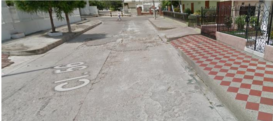
Imagen 112. Condición actual de la calle 56. Fuente: Google Earth.
