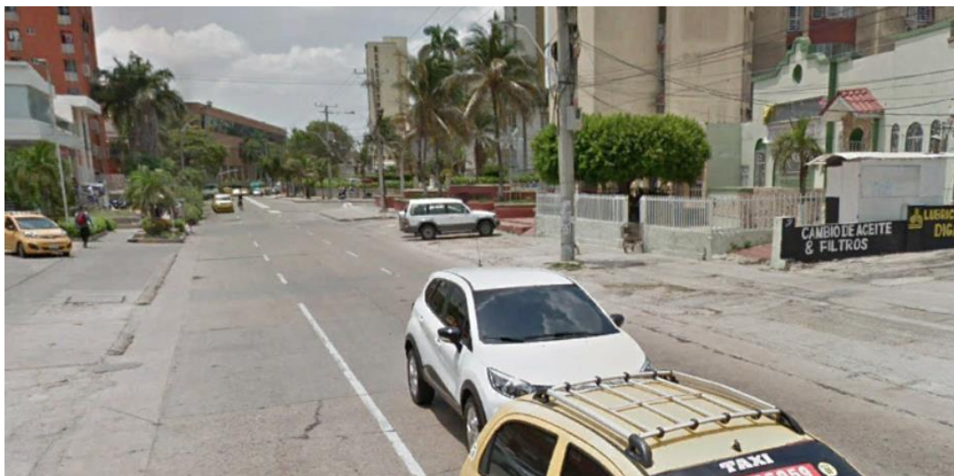
Imagen 106. Condición actual de la calle 53 en la zona del proyecto.
