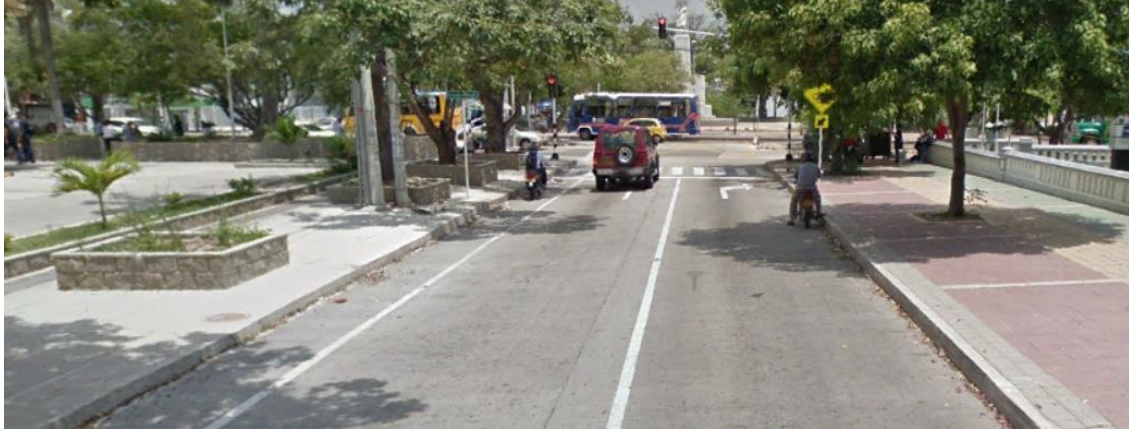
Imagen 110. Condición actual de la calle 55 en la zona del proyecto.
