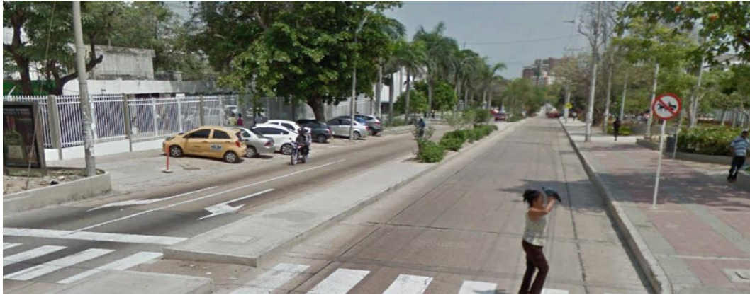
Imagen 114. Condición actual de la calle 52 en la zona del proyecto.
