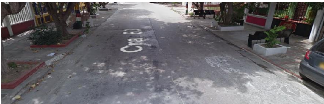
Imagen 147. Condición actual de la carrera 63.
