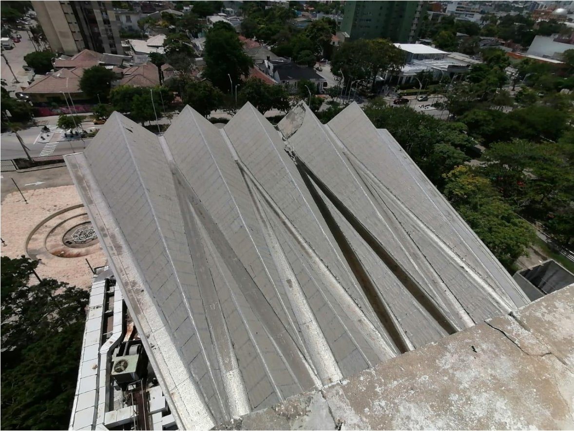
Imagen 28. Cubierta de pliegues alternados del Teatro Municipal Amira de la Rosa.
