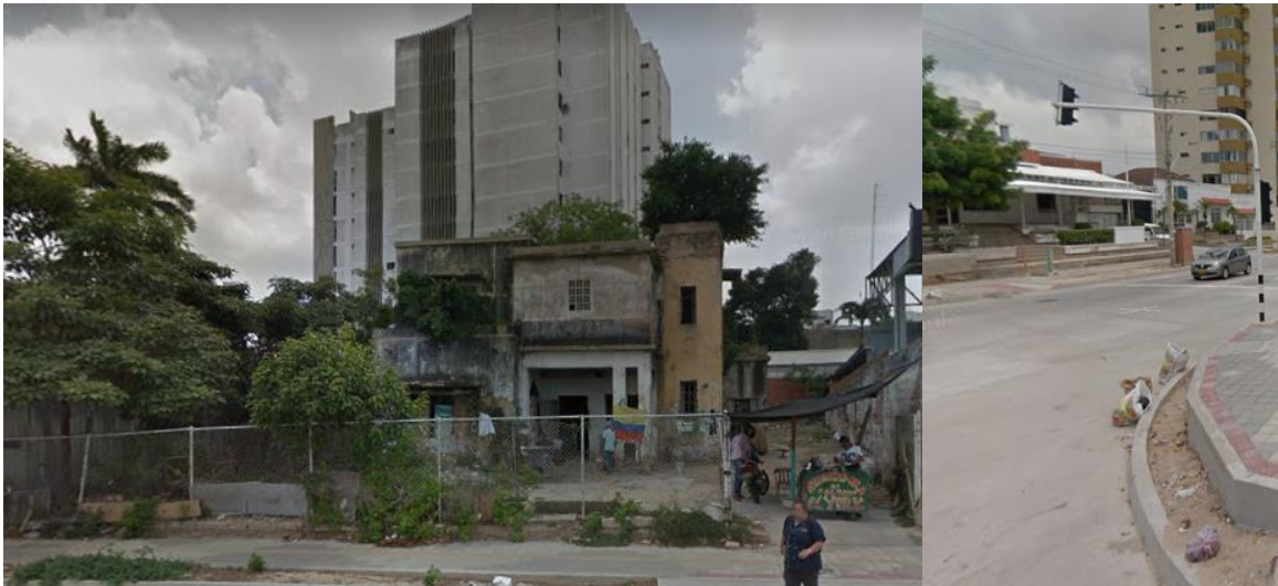
Imagen 85. Edificación abandonada: acumulación de desechos y crecimiento de maleza. A. Calle 59 entre carreras 53 y 54, y B. acumulación de residuos sólidos en vía pública (carrera 53 con calle 59).
