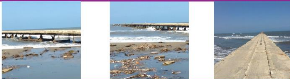
Puerto Colombia: Muelle de Puerto Colombia (2016)
