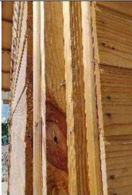
Foto No. 11 En las uniones de las columnas los tornillos perforan el total de la Columnade madera
