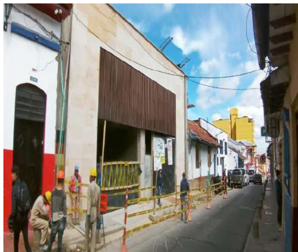
Ilustración 2 Obra de ampliación del ICANH
