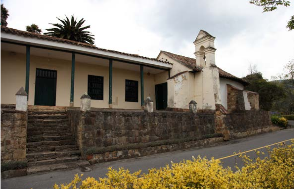
Se realizó la rehabilitación y restauración integral de la casa Rivas Sacconi, propiedad del Instituto Caro y Cuervo. Fuente: Archivo Ministerio de Cultura
